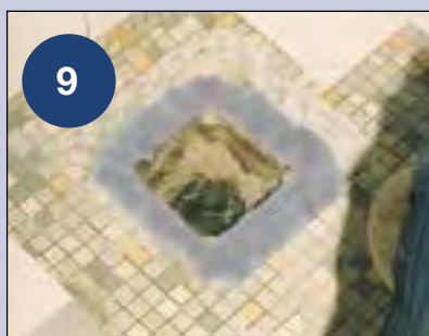
Tætningsmassen fyldes op til over gulv afløbets kant og fylder flangen ud.
