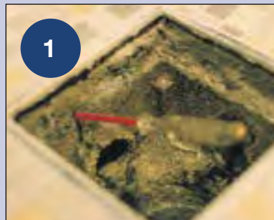
Eksempel på en tiltrængt renovering og hvor en nærmere undersøgelse viser, at der er huller i opstøbningen.
